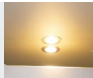
Éclairage de la zone de passage
